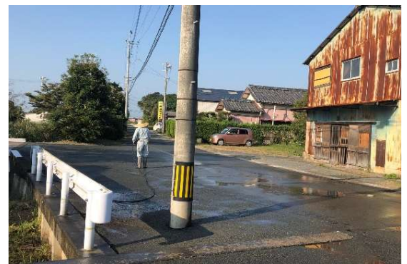
【高圧洗浄機での道路清掃】
